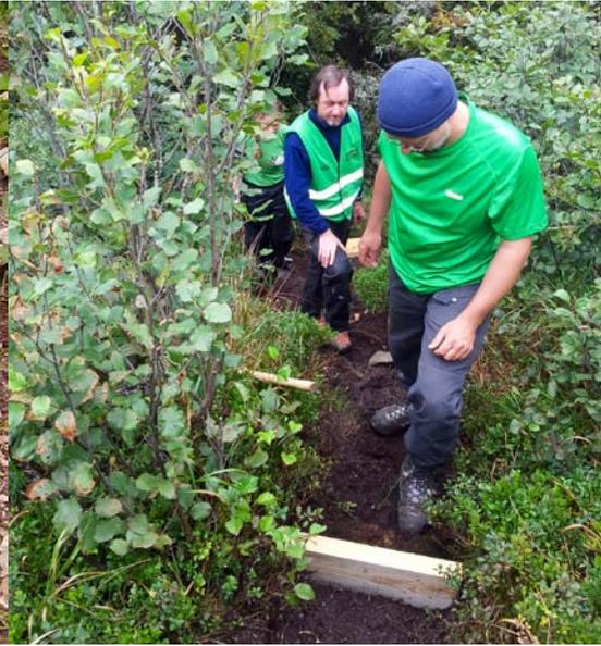
genen Sommers nicht entmutigen ließen, und die in einer wahren Blitzaktion 14 Trittstufen gesetzt und zwei Wegkorrekturen fertiggestellt haben. Für diese Aktion hatten wir unter anderem die Lastenkraxe mit vier Lärchenstufen, zehn Eisenstangen und diversen Kleinigkeiten beladen.
