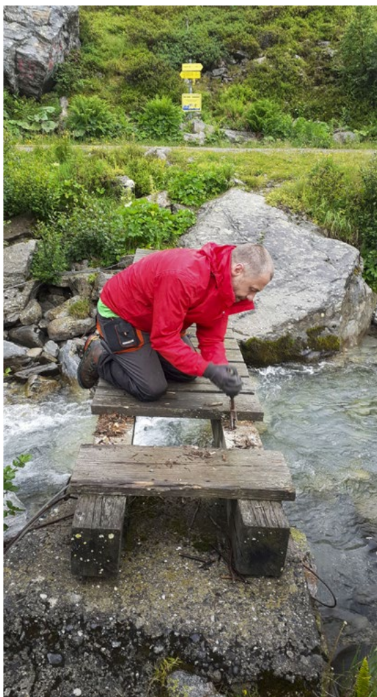
Die Brücke am Weg zum Kuchenjoch wurde ausgebaut
